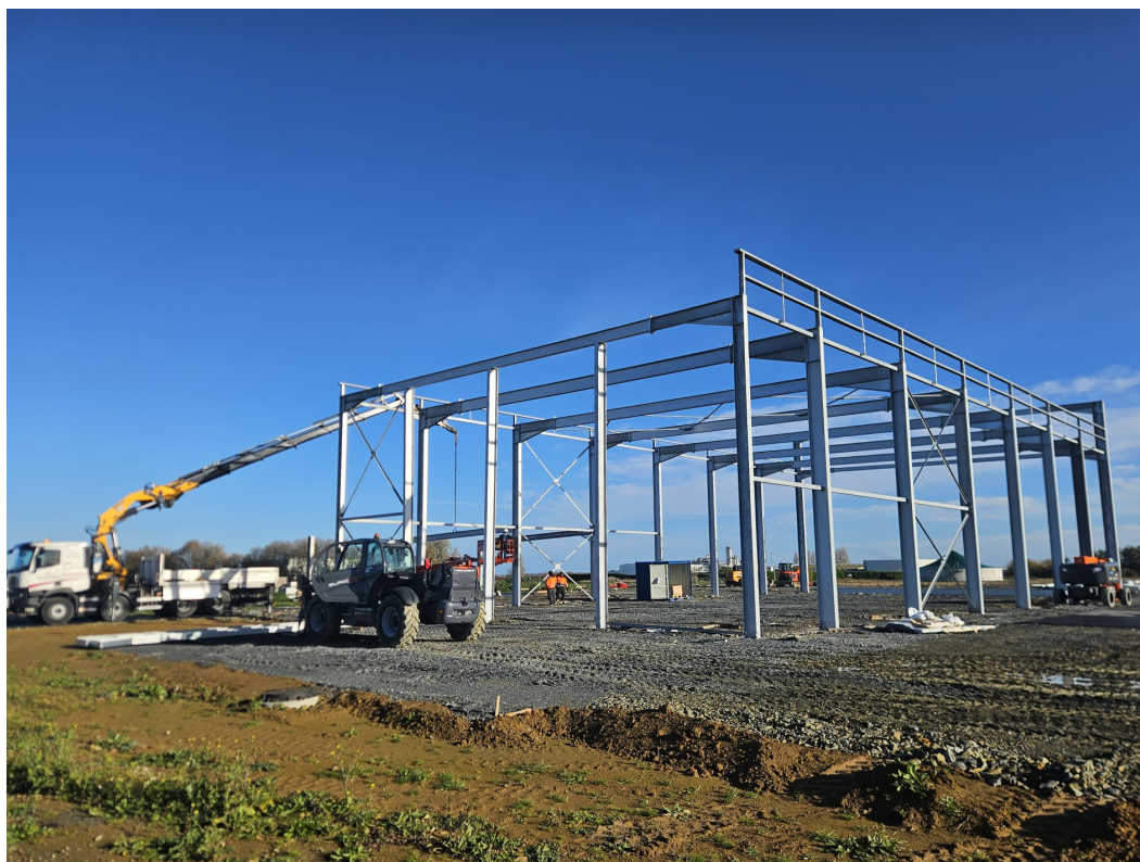
Avancé du chantier, octobre 2025
